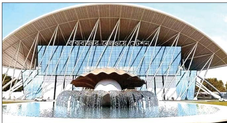
নির্মাণাধীন কক্সবাজার রেলওয়ে স্টেশন
